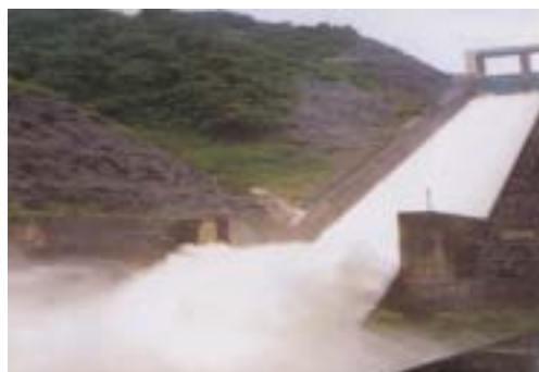
洪水調節する洪水吐ゲート(手取川ダム)
