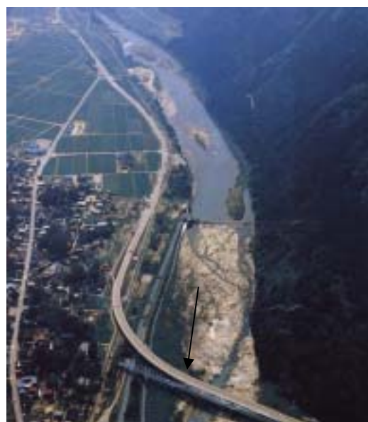
中流域（白山合口堰堤付近）
