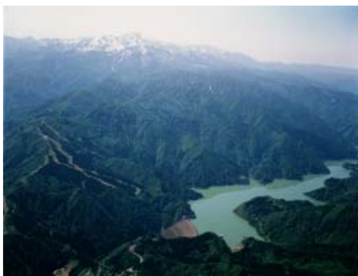
上流部 手取川ダム (手取川ダム湖と白山)
