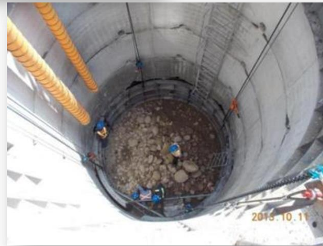
場鑄混凝土套環擋土壁施工
