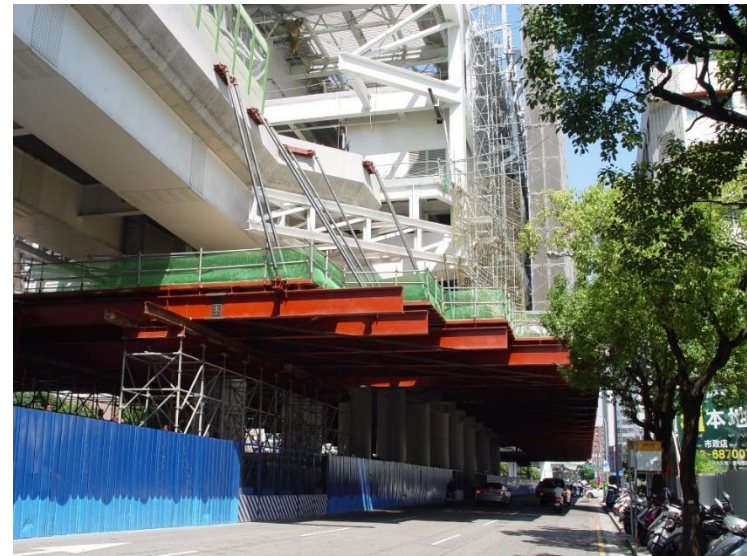
懸臂施工平台之應用案例 —臺中捷運綠線G9車站
