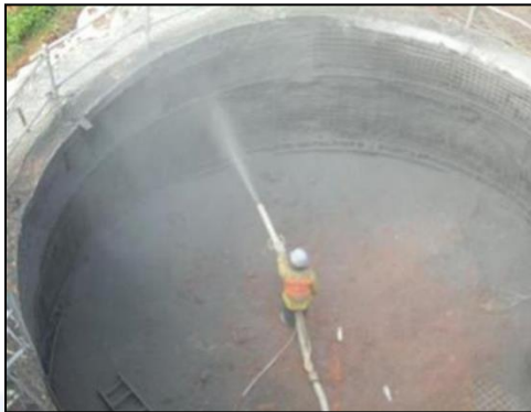
傳統噴凝土擋土壁施工
