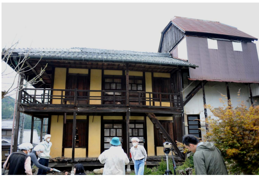
左が研究棟、右が土蔵の上に増築された第二観測室
