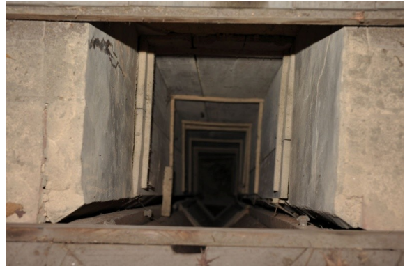
三角屋根回転ドームの内部（魚眼レンズ撮影） 望遠鏡のピアーを貫き地下室までつづく深さ 7m の縦抗
