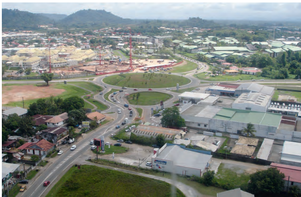
Rond point de la Madeleine avec le chantier d'agrandissement de l'hôpital (Cayenne) © TUTTLE Joe
