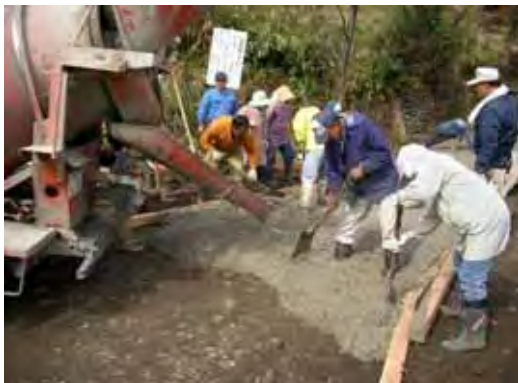
生コン車からコンクリート打設
