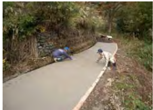
金ゴテによる仕上げ
