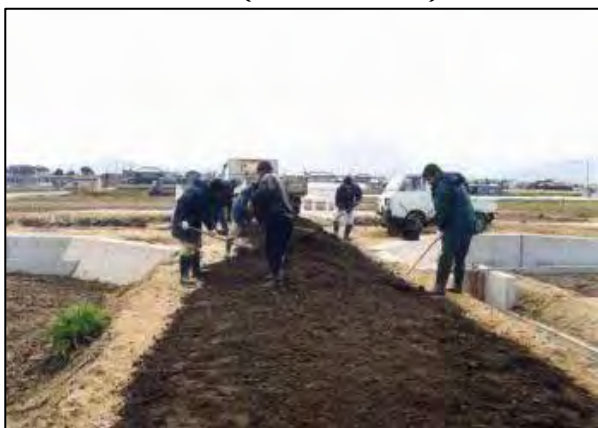
(敷砂利舗装工)
