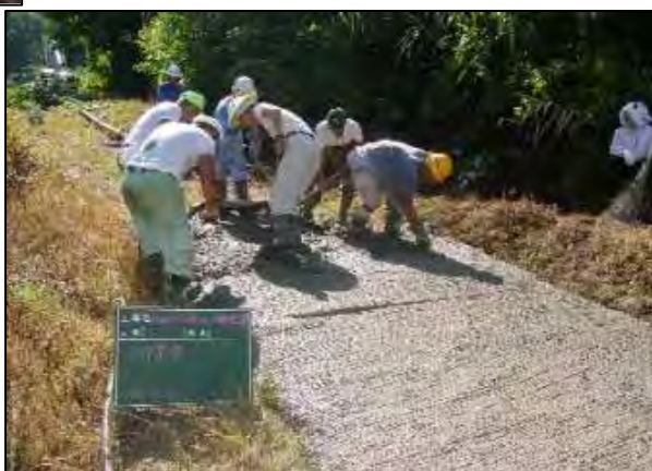
(コンクリート舗装工)
