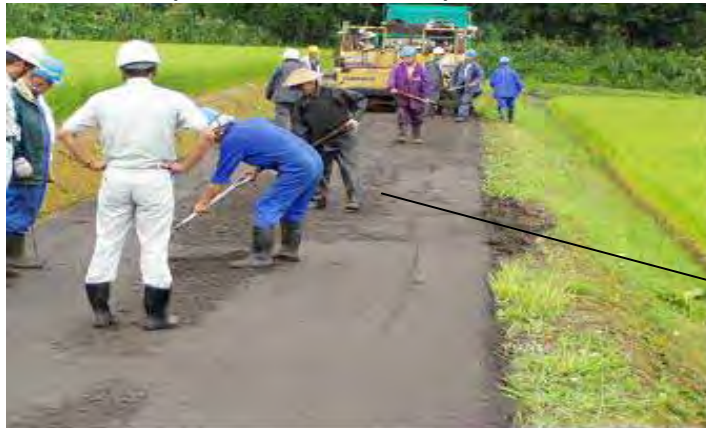
(直営施工の状況写真)
