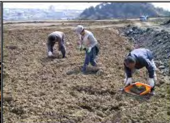
(石れき除去工)
