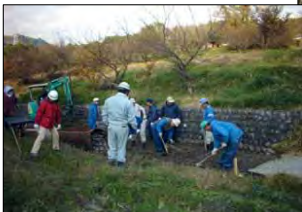
(敷砂利舗装工)
