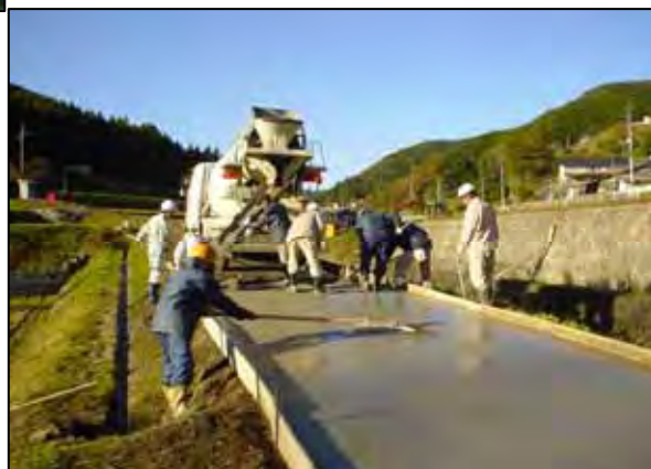
(コンクリート舗装工)
