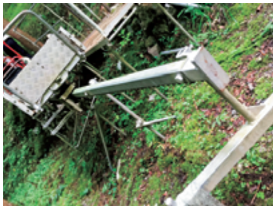
<モノレールの支柱>
