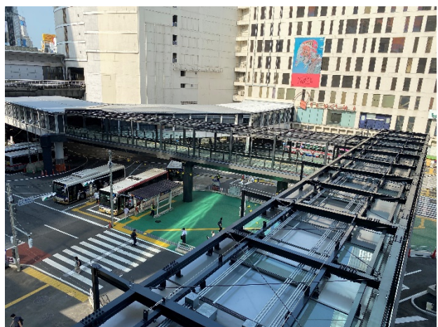
歩行者デッキ全景（渋谷フクラスから見る）
