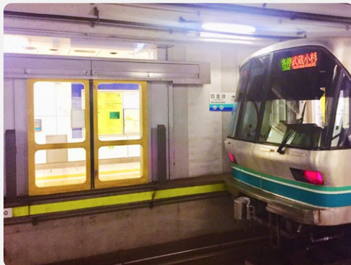
▲手前のホームドアは現在未使用 8両編成化に伴い改修予定
