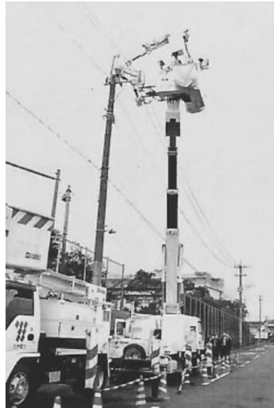
写真3.2.3 活線作業ロボットシステム Phase II
