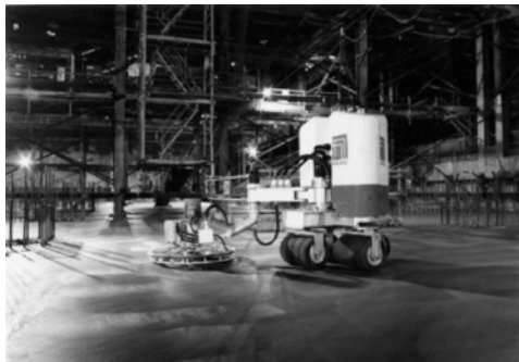
写真3.1.3 コンクリート床直仕上げロボット
