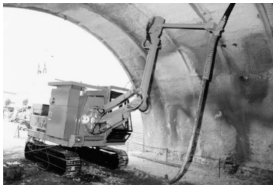
写真3.1.11 コンクリート吹き付けロボット
