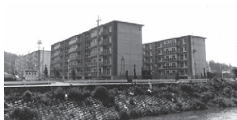
初の中高層住宅(南瀬谷団地)
