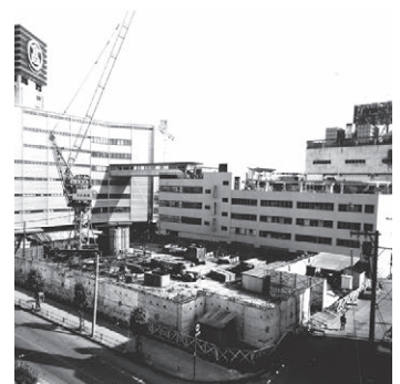
新相鉄ビル建設工事(Aブロック)
