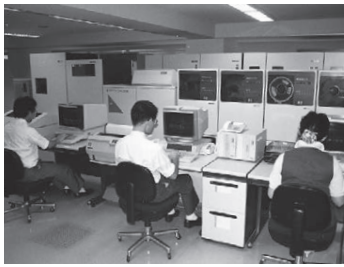
相鉄本社ビル電算機室
