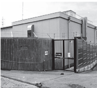
上星川変電所
