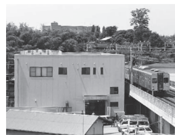
二俣川変電所
