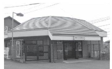
かしわ台駅東口新駅舎
