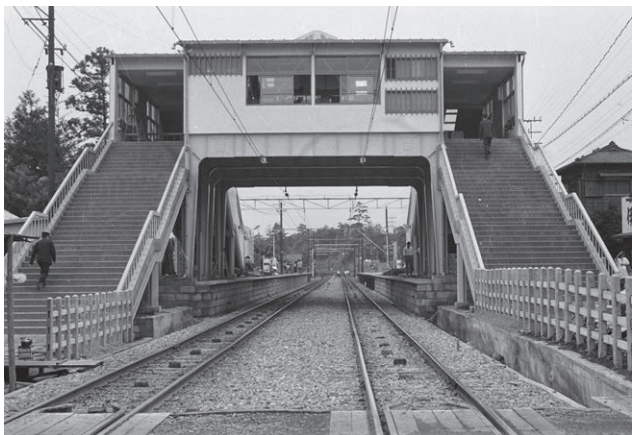
鶴ヶ峰橋上駅舎
