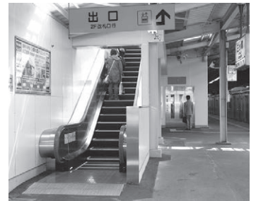
駅のバリアフリー化(三ツ境駅のエスカレーター・エレベーター)
