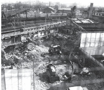
新相鉄ビル建設工事(Bブロック)
