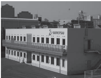
西横浜駅構内の電車区・車掌区分室
