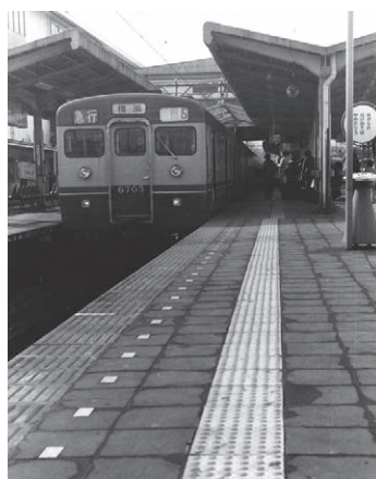
二俣川駅の点字ブロック
