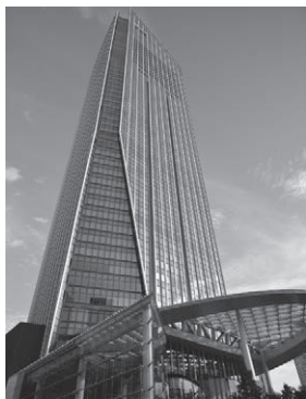
管理業務を受託した「虎ノ門ヒルズ森タワー」
