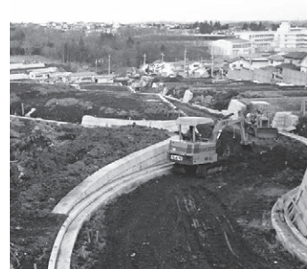
造成中のかしわ台住宅地
