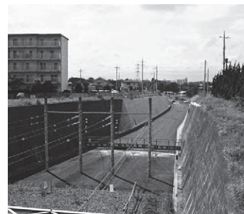
いずみ野線延伸工事(いずみ野駅構内)
