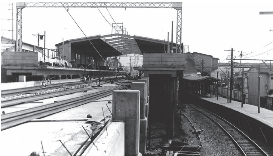
天王町駅工事風景
