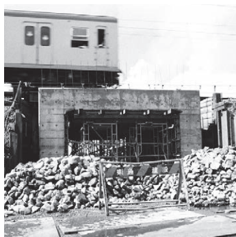
三ツ境3号踏切道地下道化工事
