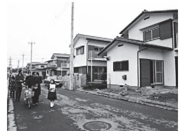
多くの見学者が訪れたいずみ野住宅地
