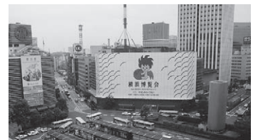
解体工事を控えた旧・相鉄ビルに設置した「YES'89」PRボード
