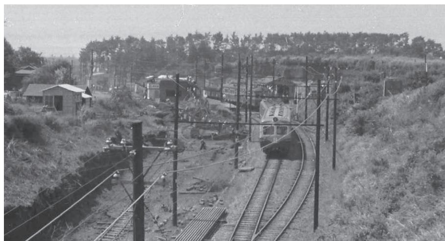
複線工事中の三ツ境駅付近
