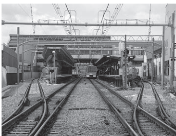
新設された瀬谷駅下り待避線(左端)
