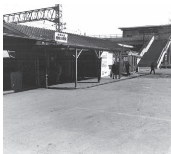
相模大塚駅(右は工事中の橋上駅舎)
