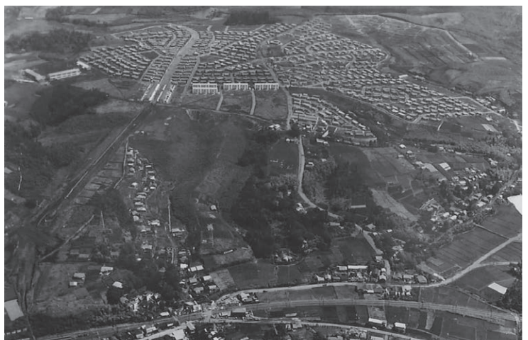
二俣川駅までの道路を建設中の万騎が原団地
