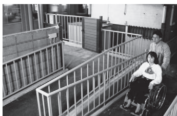
車いす専用スロープ
