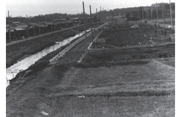
建設半ばの瀬谷、深見団地
