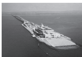
橋脚の土台となる基礎石などを納入した東京湾横断道路(アクアライン)工事
