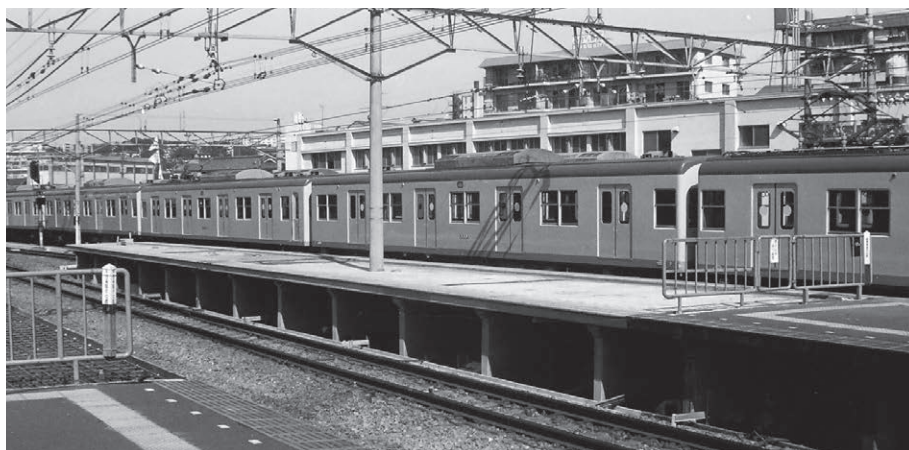
完成した星川駅のホーム延長工事
