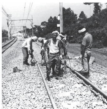
相模大塚～海老名間複線化工事
