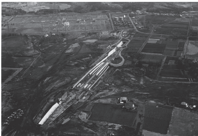
建設が進むいずみ野線(いずみ野駅)
