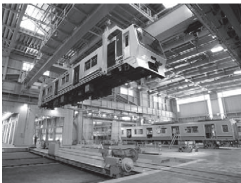
オーバーヘッドクレーン
