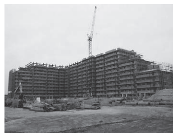
工事中のステージ星川
