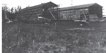
建設中の希望ヶ丘高校校舎
