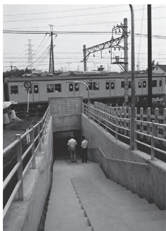
第1 希望ヶ丘地下道(旧希望ヶ丘2号踏切道)
