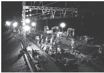
大和駅周辺連続立体交差工事、深夜の線路切替え
