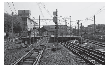
二俣川駅構内4線化工事
