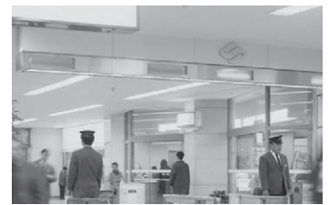
改札口上部の出入口表示機
