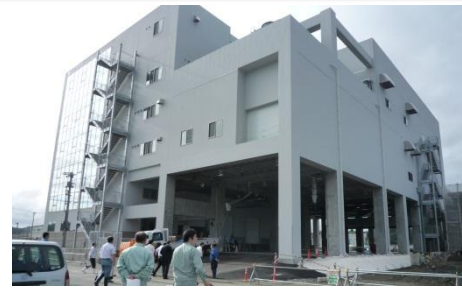
製氷・貯氷施設 (宮城県気仙沼市) 平成24年3月交付決定。 平成24年10月中旬から稼働開始。
