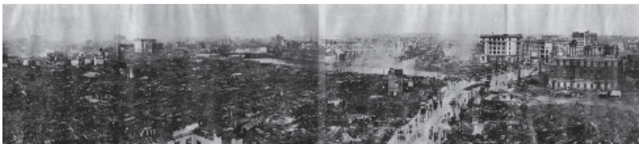
写真-1-2 京橋の第一相互ビルディングより見た日本橋及び神田駅方面の惨状
