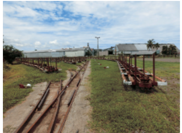
写真-23 サトウキビ運搬貨車の集積場。分岐器とダルマポイントが規則正しく並んでいて、幾何学的に美しい配線となっている。（南西を見る。2014年2月23日）
