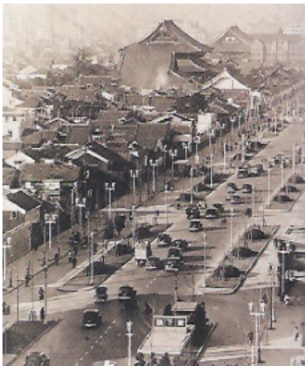
写真-2-4 完成した御堂筋
