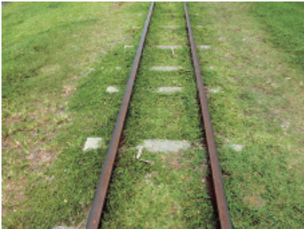
写真-22 超狭軌（軌間610mm）のサトウキビ鉄道。レールは60ポンド/m（約27kg/m）、短いながらもコンクリート枕木を使用。軌道は芝生におおわれている。（西を見る。2014年2月23日）
