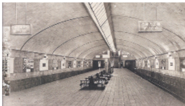
写真-2-5 淀屋橋駅プラットフォーム
