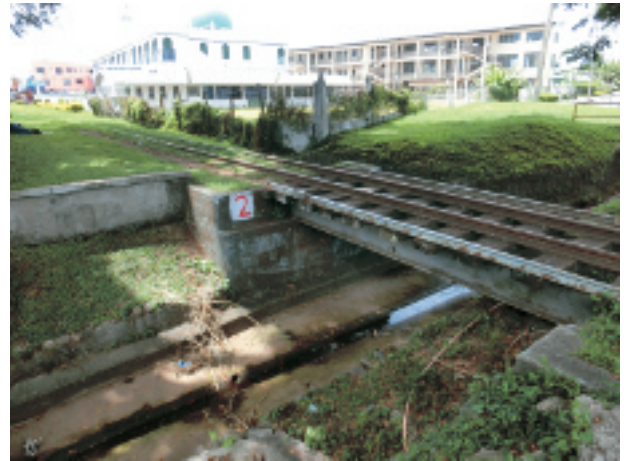
写真-20 ラウトカ中心部を走るサトウキビ鉄道と短い上路プレートガーダー橋梁。奥にナトログ=モスクが見える。（南東を見る。2014年2月23日）
