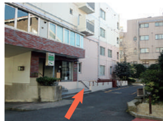
リバティホール入口 (外階段を降りた地下)
