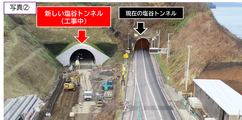
▲小樽市側坑口(令和2年11月末時点)
