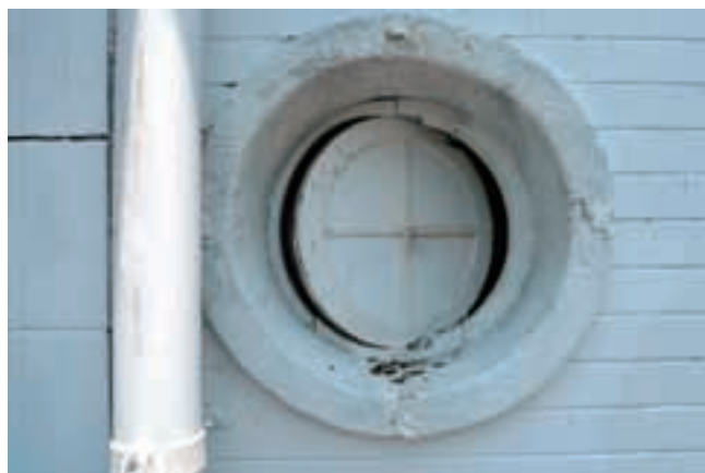
シンプルなデザインの中で存在感を示す円形窓。建築物としての趣は無視され、外壁は白く塗られている（2010年撮影）。
