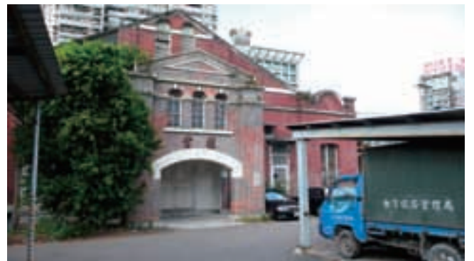
旧台湾総督府鉄道部講堂。清国統治時代の鉄道遺跡として注目されている。ただし、保存状態はよくない。
