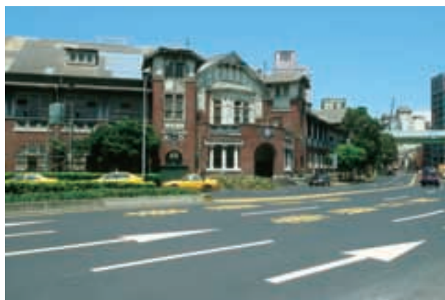
旧台湾総督府鉄道部庁舎。その優美な姿は、威厳と風格が重視された当時の建物の中では異色の存在とされていた。本稿執筆時、修復工事が進められている（写真は2007年撮影）。
