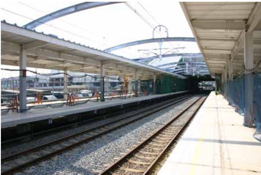
建設中の「流山おおたかの森」駅
