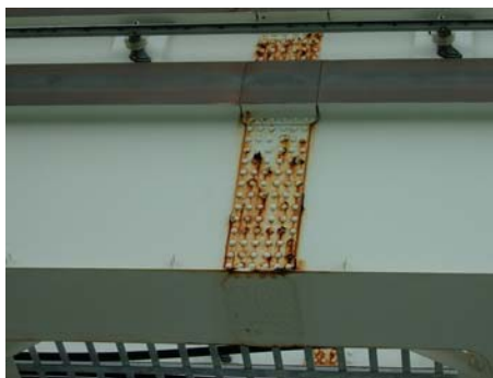
写真－1 モノレール桁のボルト部腐食状況
