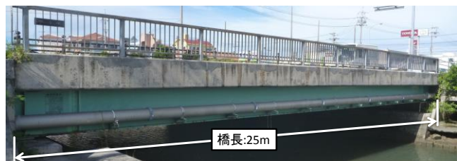
写真 1 対象橋梁全景
