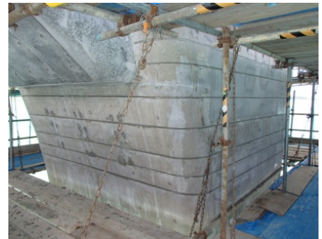
写真-4 P6 橋脚陽極設置状況
