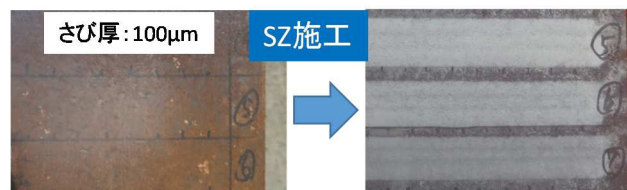
図-3 試験体外観
