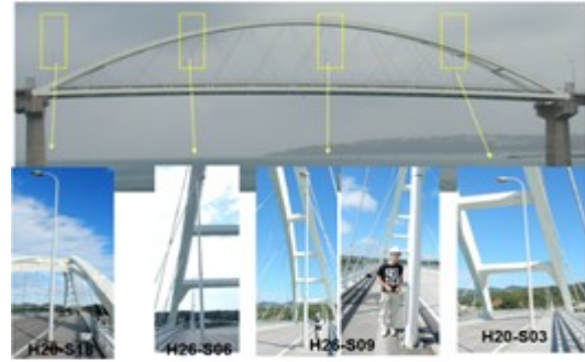
図-1 対象照明柱の位置
