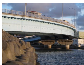
図-1 M 橋全景
