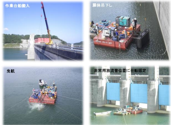
写真-2 仮設止水用ゲートの曳航状況
