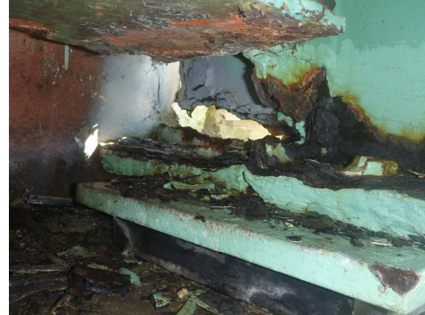
図-1 桁端部の腐食事例
