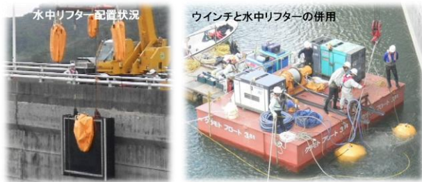
写真-1 水中リフター・ウインチ配置状況
