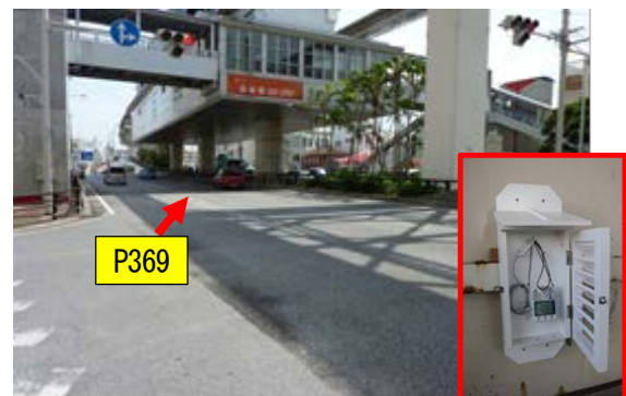
写真-1 安里駅下の中央分離帯 P369 橋脚
