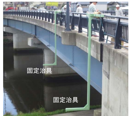
図4 点検時 治具設置状況
