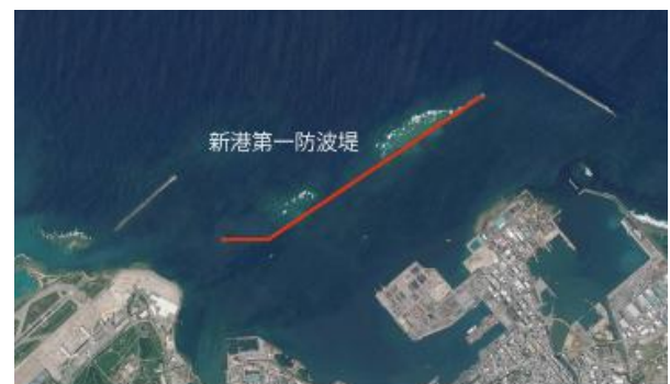
図-1 新港第一防波堤位置（那覇港）
