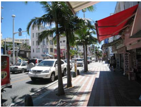
写真10 施工完了後の状況
