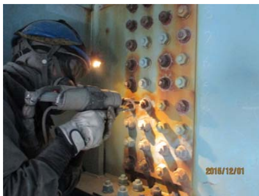
写真－3 CS施工状況
