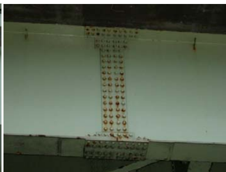
写真－2 道路橋主桁ボルト部の腐食状況
