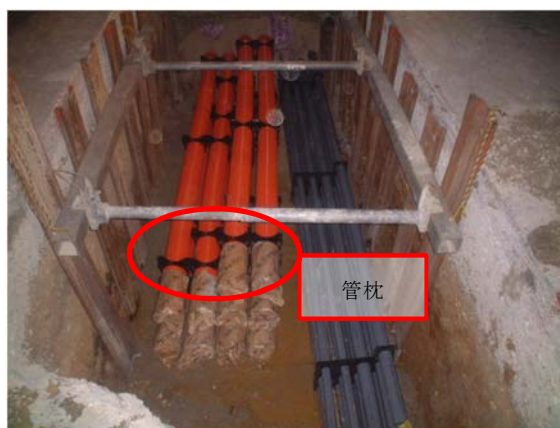
写真8 C・C・BOXの施工状況
