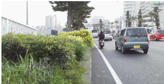
写真-3 植栽が繁茂して車道部へはみ出ている様子
