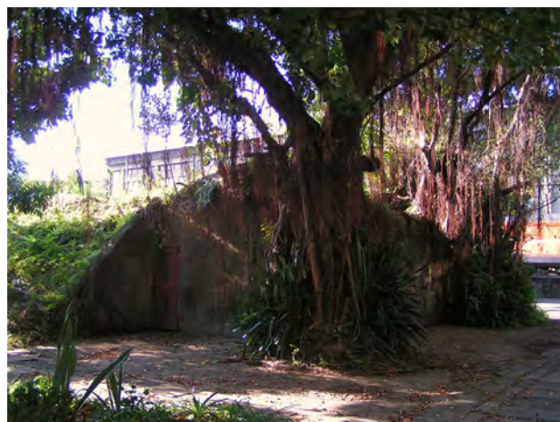
【照片 4-7】臺北機廠現存可見之防空洞。 資料來源：本研究拍攝。
