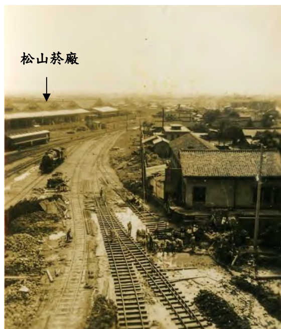
【照片 4-22】戰後臺北機廠進出廠線之軌道鋪設。資料來源：臺北機廠技術組提供。
