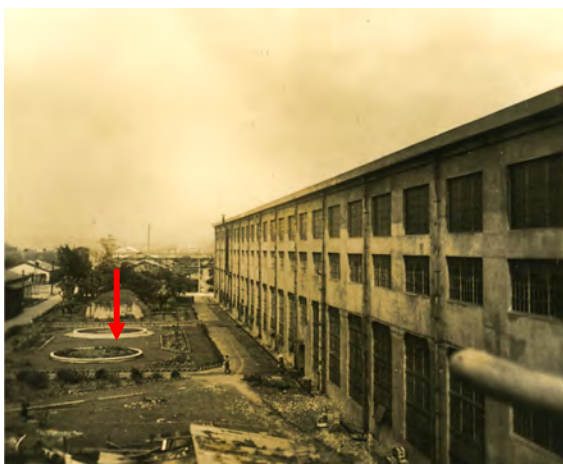
【照片 4-6】臺北機廠原設置之防空洞。 資料來源：臺北機廠技術組提供。
