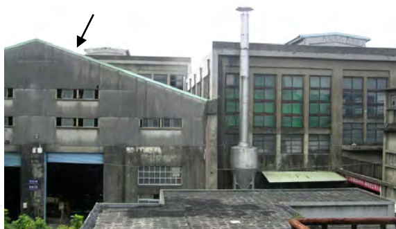
【照片 4-3】柴電場區東側建築立面外觀。 資料來源：本研究拍攝。
