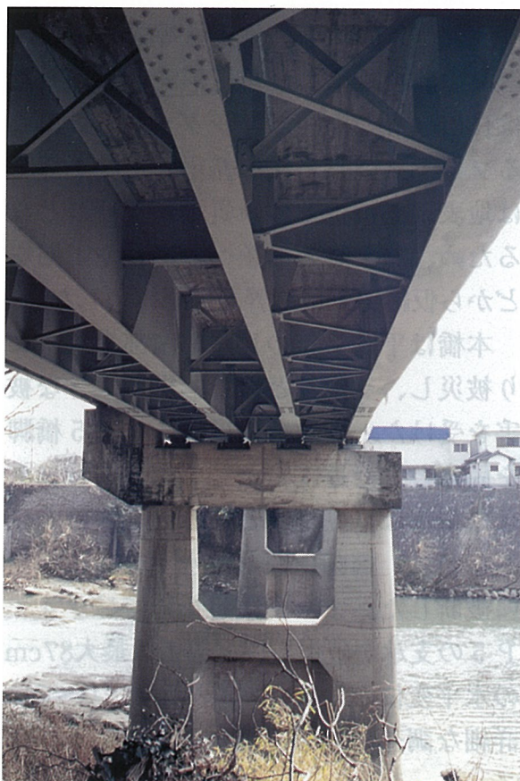
桁内部の状況
