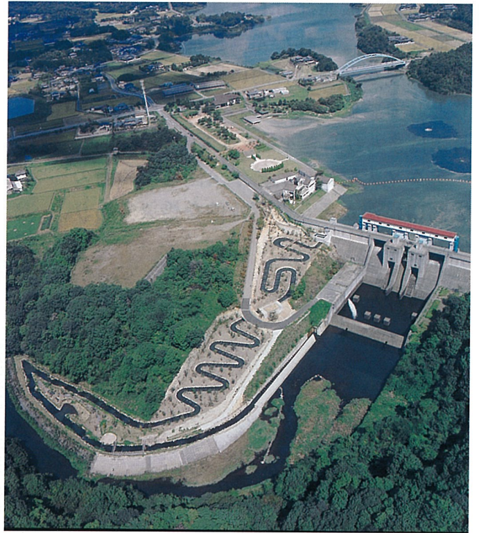
整備されたダム魚道と末吉橋
