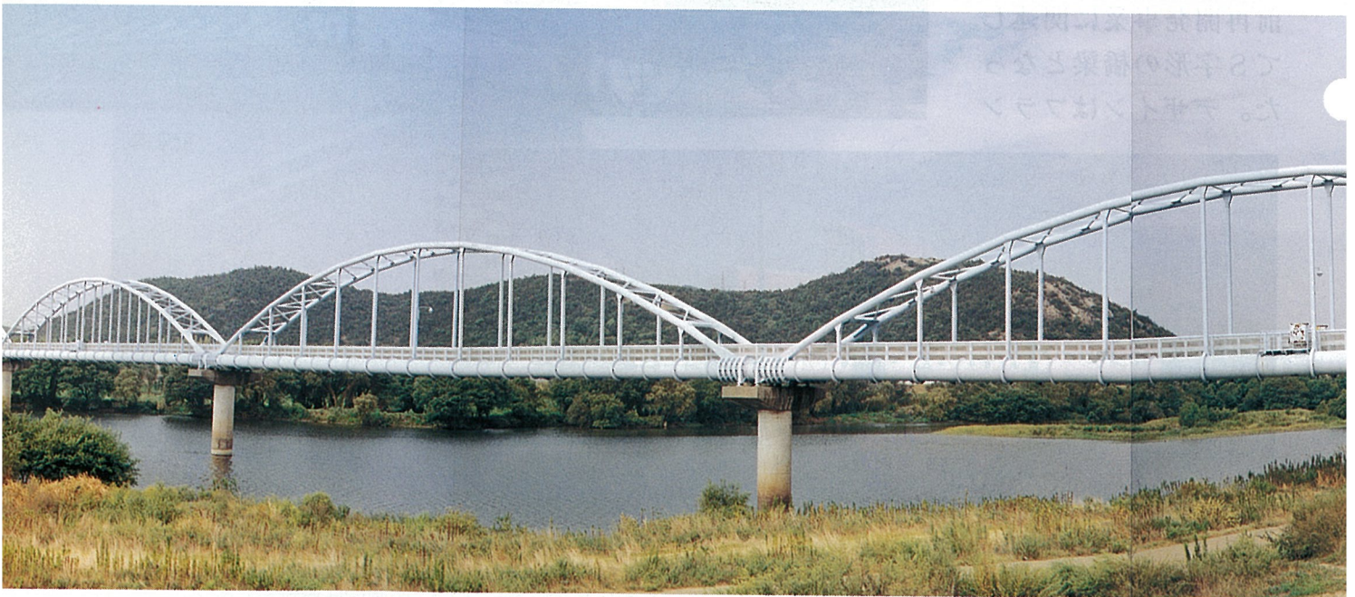
加古川水管橋
