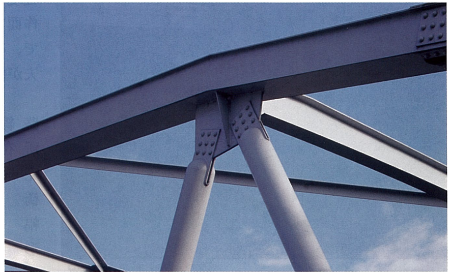
格点の構造は静的引張試験、疲労試験の結果を考慮して決定した
