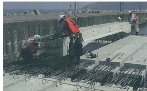
写真 - 2 プレキャスト PC 桁架設状況 3)
