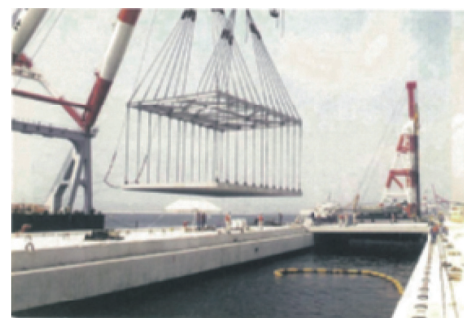
写真 - 3 一括架設の事例(神戸港) 3)
