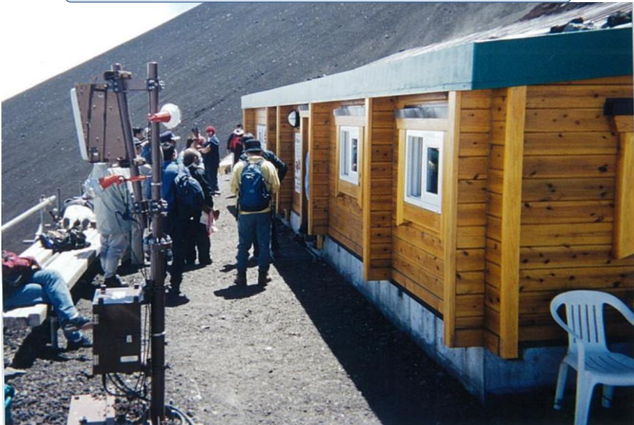
トイレが整備された後、し尿の放出はなくなった。
