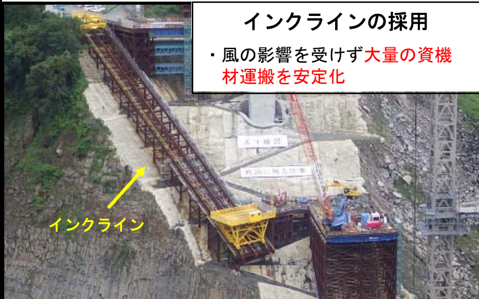
下部工施工時
