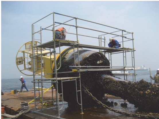
図 5.1.4-1 引上げたブイと作業用の足場
