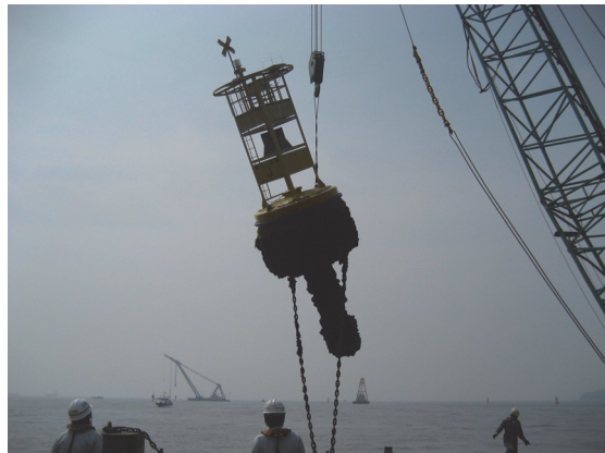
図 5.4-2 クレーンによるブイの引上げ (株式会社ゼニライトブイ 提供)
