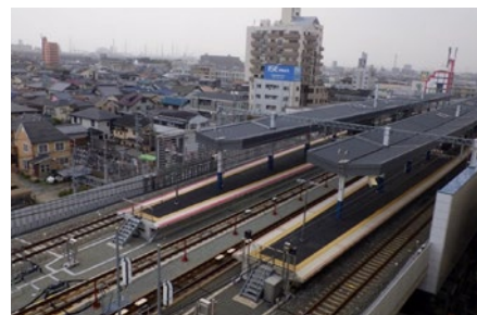
高石市内連続立体交差事業(高石駅部)
