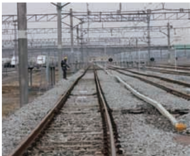
写真 2.1.37 軌道の変位（新幹線総合車両センター）
