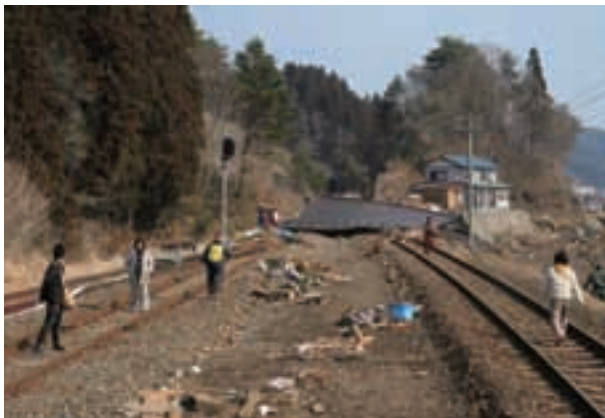
写真 2.3.16 田老駅付近の線路上の瓦礫
