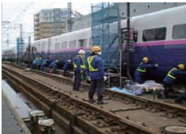
写真 2.1.35 脱線復旧作業その 2
