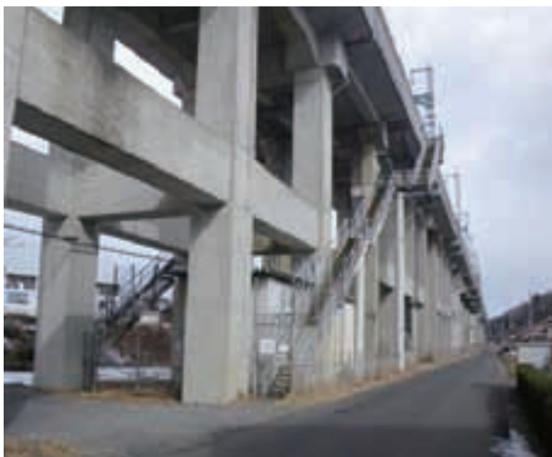
写真 2.1.8 新幹線の保守用門扉
