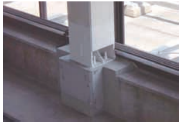
写真 2.5.12 八乙女駅上屋支柱の復旧状況 (被害状況は写真 2.5.4 参照)
