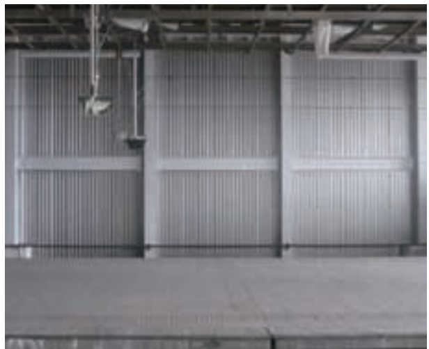
写真 2.1.32 ホーム階段室壁復旧
