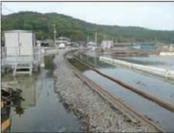
写真 2.2.17 線路の冠水(沢田駅～浦宿駅間)
