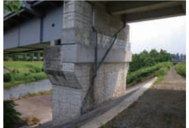
写真 2.5.11 七北田川橋りょうの復旧状況 (被害状況は写真 2.5.3 参照)
