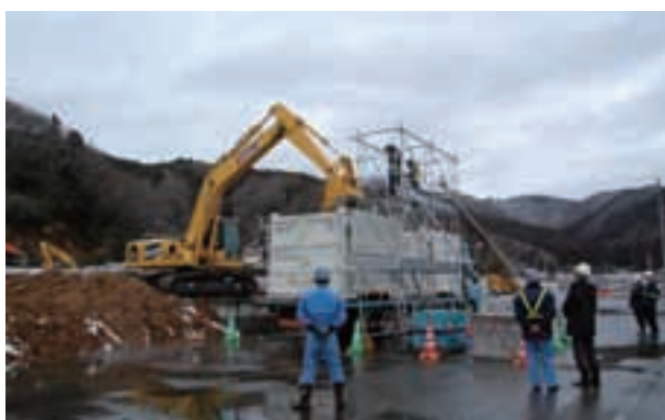
写真 2.9.5 コンテナで災害廃棄物輸送
