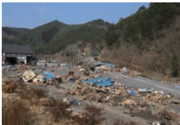
写真 2.3.9 津波が到達した田野畑駅前
