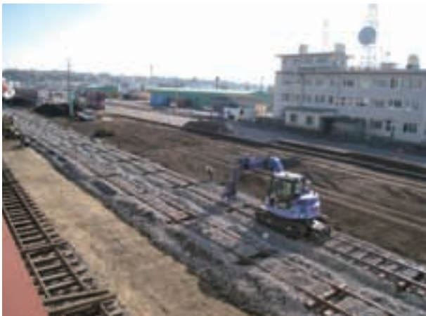
写真2.13.5 10月に開始された小名浜駅の復興工事
