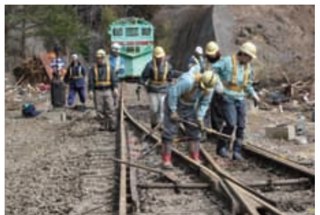
写真 2.3.17 社員による復旧作業の様子
