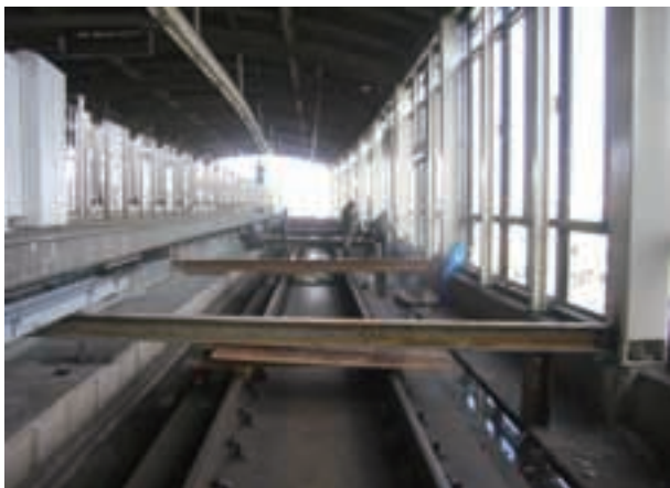
写真 2.5.5 八乙女駅の応急処置状況
