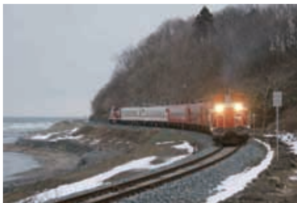
写真 2.2.35 試運転列車（陸中八木駅～宿戸駅間）
