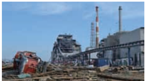
写真 2.9.2 壊滅した石巻港駅
