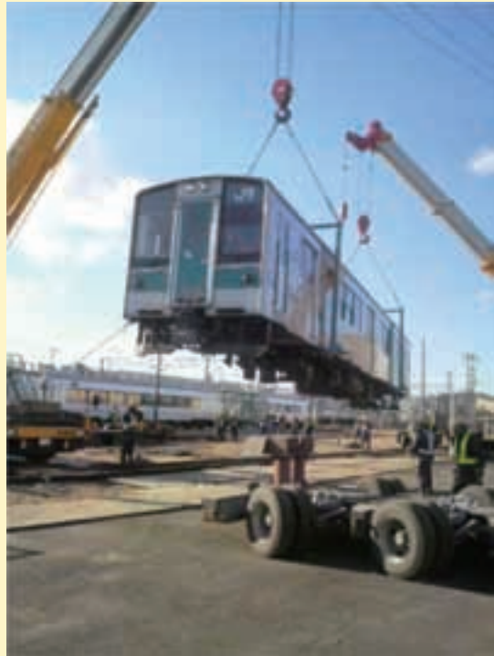
写真1 郡山総合車両センターからトレーラーにより陸送された701系車両
