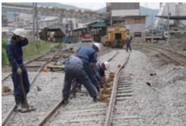
写真 2.11.4 社員による線路復旧
