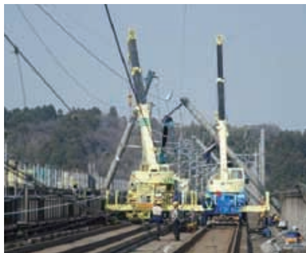
写真 2.1.29 電化柱の撤去
