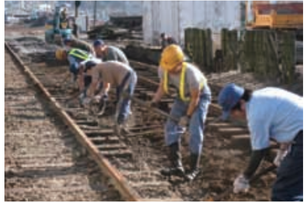
写真 2.13.4 社員による軌道復旧工事
