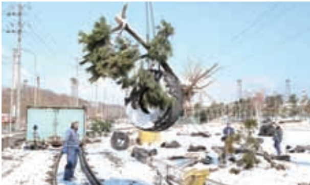
写真 2.10.4 北沼駅構内の瓦礫撤去
