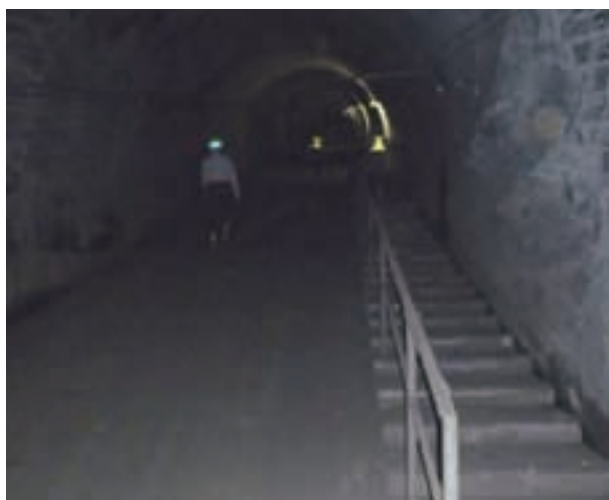
写真 2.1.5 トンネル斜坑
