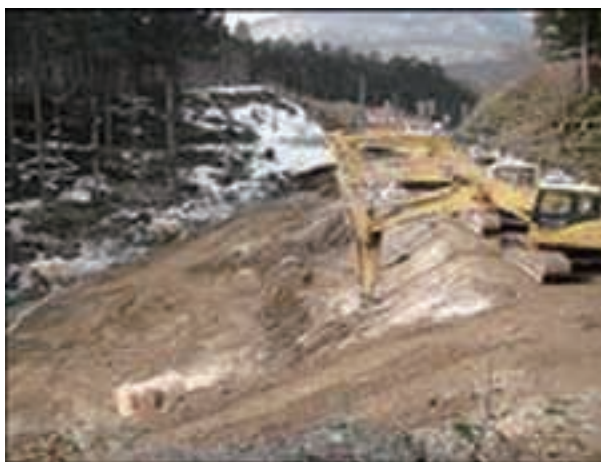
写真 2.2.50 復旧工事（仙山線）
