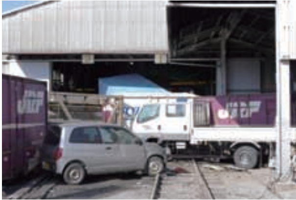
写真 2.13.3 津波により車、コンテナで満杯の機関車車庫
