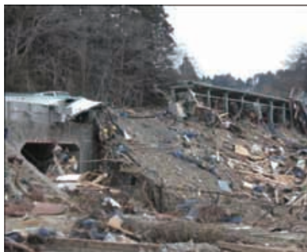
写真 2.2.24 駅舎の流出(陸前港駅)
