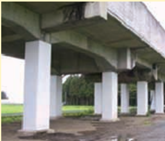
写真1 高架橋の耐震補強対策について
