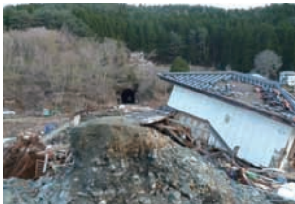
写真 2.3.4 波が築堤を破壊した泊地区
