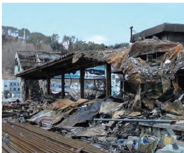
写真 2.2.39 駅舎損傷・焼損（陸中山田駅）
