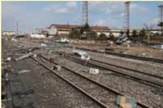
復旧前（八戸臨海鉄道）
