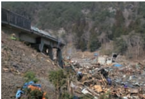
写真 2.3.1 駅と高架橋が流出した島越駅付近
