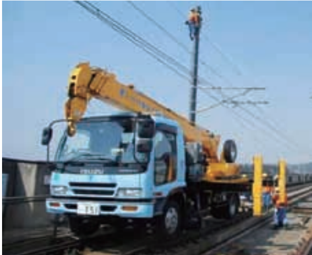
写真 2.1.30 電化柱の立替
