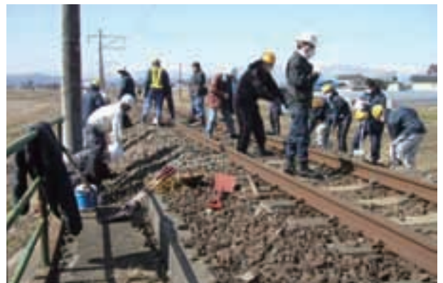
写真 2.6.5 復旧作業（二井田駅～新田駅間）
