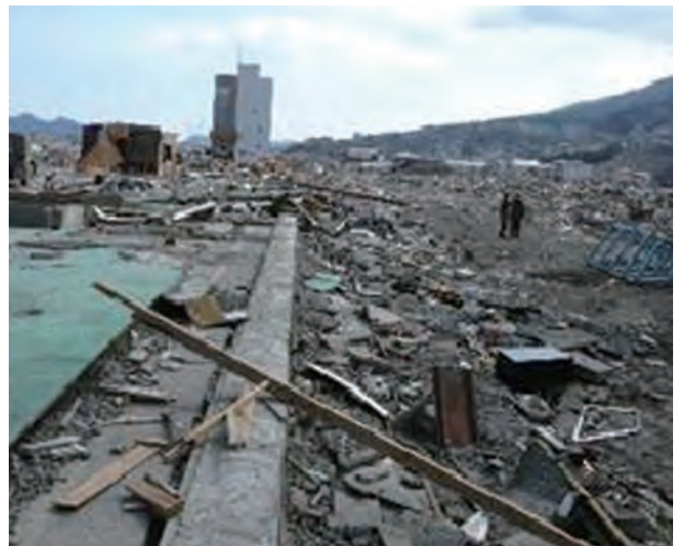
写真 2.2.46 駅舎損傷(大船渡駅)
