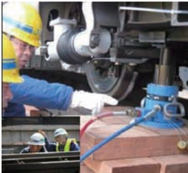
写真 2.1.34 脱線復旧作業その 1
