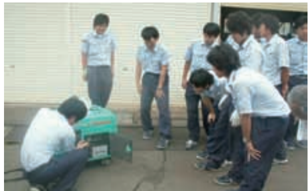
写真 2.9.6 ディーゼル発電機の取り扱い訓練
