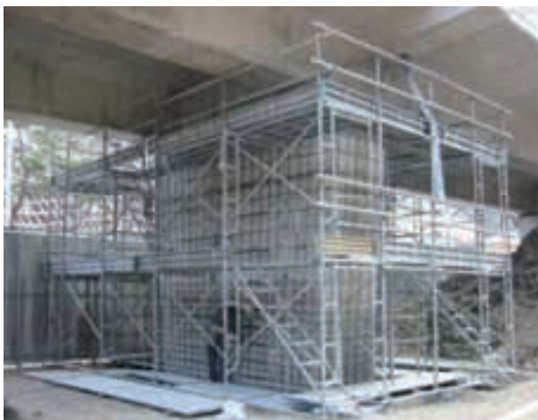
写真 2.5.1 耐震補強工事
