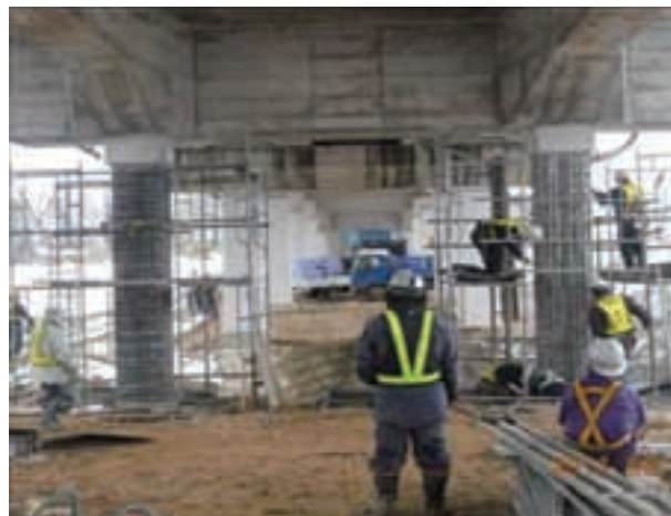
写真 2.1.28 高架橋柱の復旧作業
