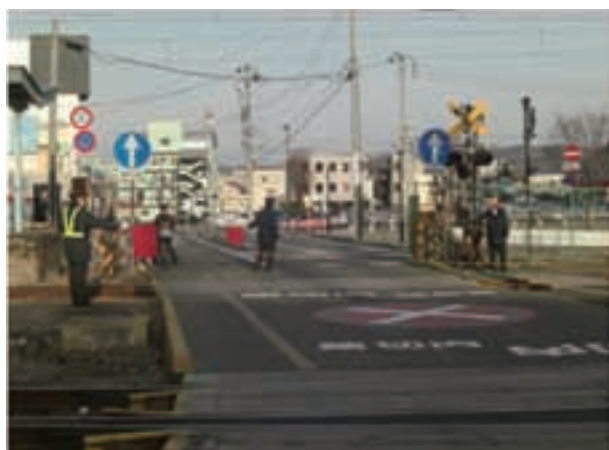
写真 2.8.2 曾根田東踏切での踏切防護
