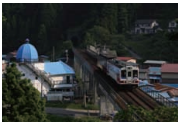
写真 2.3.7 島越駅付近被災前
