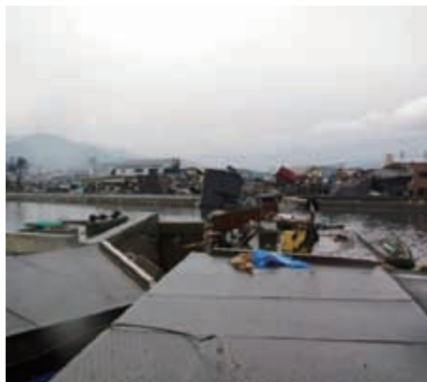
写真 2.2.23 橋桁の流失(松岩駅～南気仙沼駅間)
