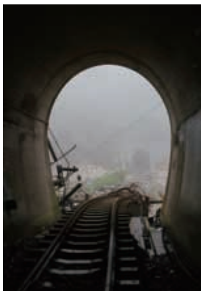
写真 2.3.3 流出したコイコロベ沢橋梁
