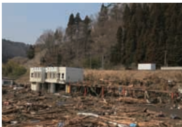
写真 2.3.10 土砂・瓦礫で覆われた田老駅前
