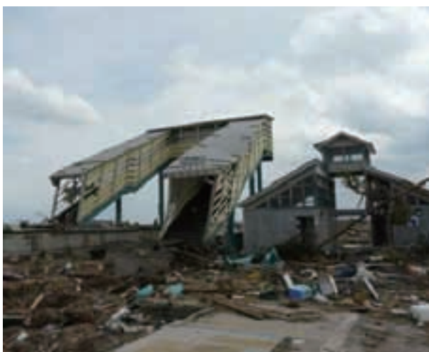
写真 2.2.10 駅舎の流失（坂元駅）
