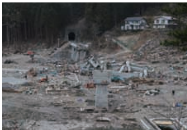
写真 2.3.8 高架橋・駅舎が流出した島越駅付近被災後
