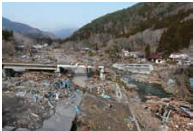
写真 2.3.15 流出した荒川橋梁付近の状況
