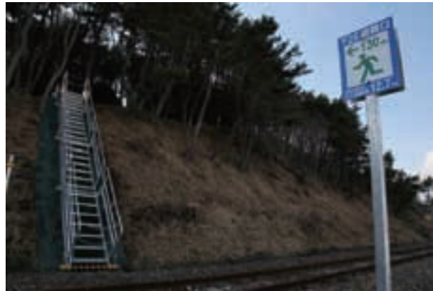
写真 2.2.30 避難通路（階段）
