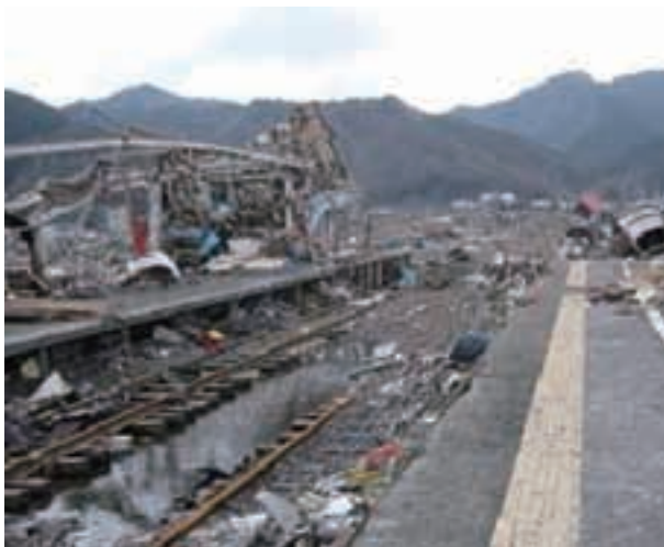
写真 2.2.41 駅舎流出（大槌駅）
