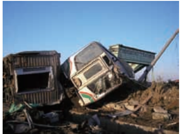
写真 2.2.11 244M列車の流失・転覆（新地駅）
