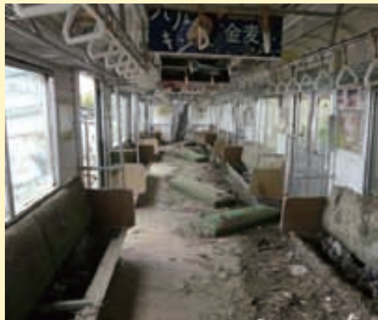
写真5 1426S車内の状況
