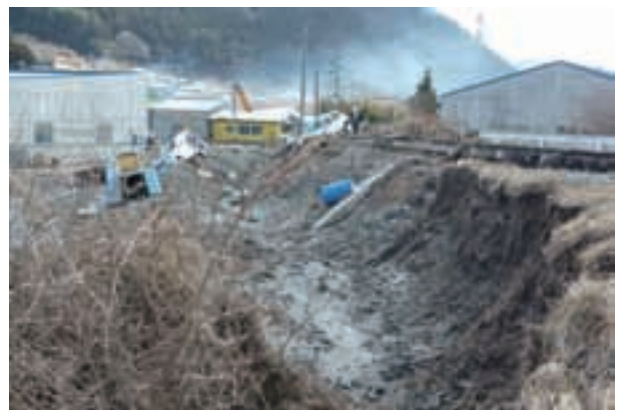
写真2.11.1 法面の流出
