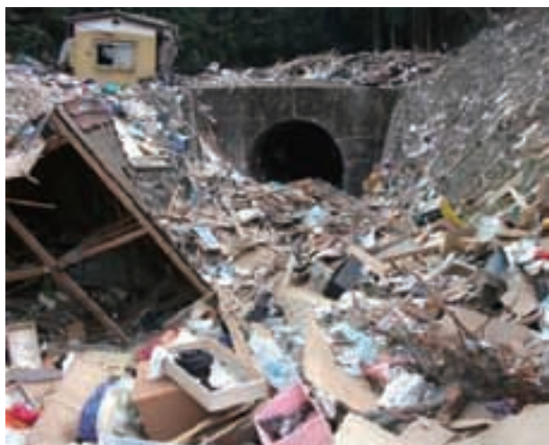
写真 2.2.20 津波襲来後の女川トンネル
