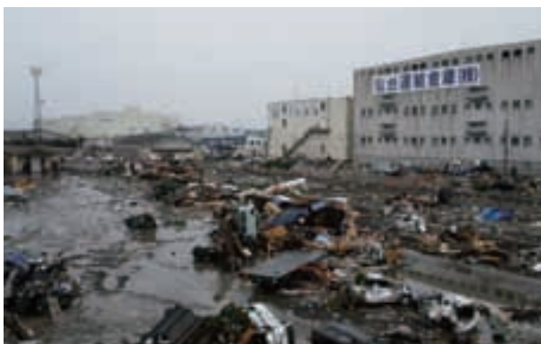
写真 2.12.1 被災直後の仙台港駅構内
