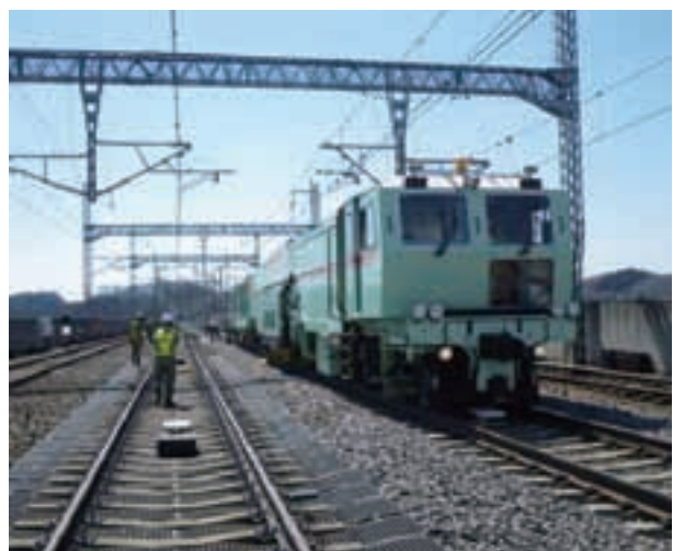
写真 2.1.26 マルチプルタイタンパー作業
