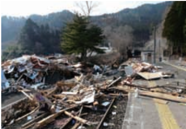
写真 2.3.12 津波が越流した唐丹駅
