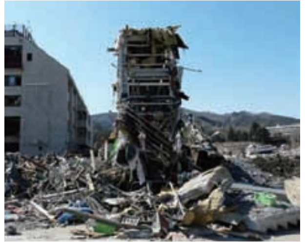
写真 2.2.18 駅舎の流失(女川駅)
