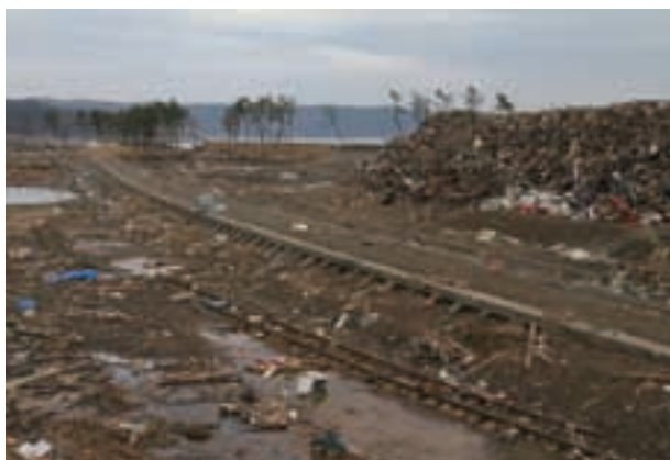
写真 2.3.2 軌道が流出した陸中野田駅～野田玉川駅間
