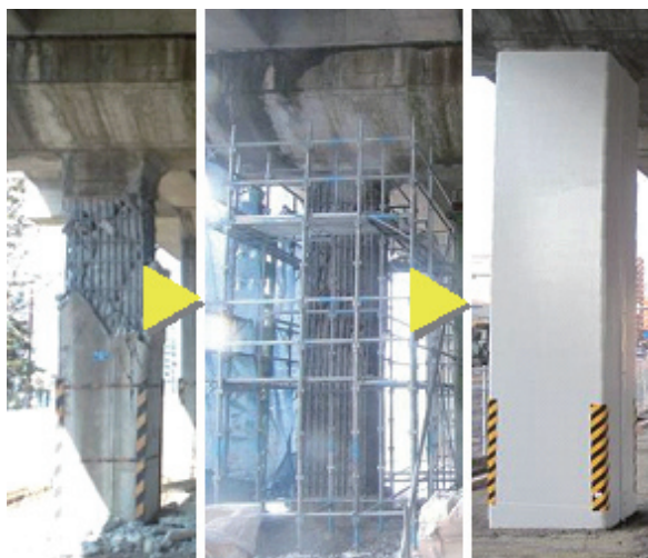
写真 2.1.27 ラーメン橋脚損傷の復旧状況 (左から被災状況，復旧中，復旧完了)
