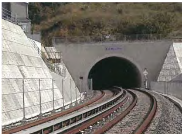
東生駒トンネル（やや扁平な断面となっている）
