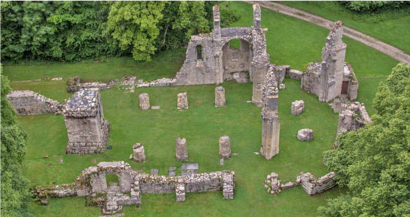
Zerstörte Kirche bei Verdun © Thorsten Hansen
