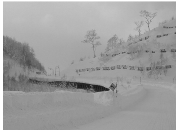
吹き上げ防止柵
