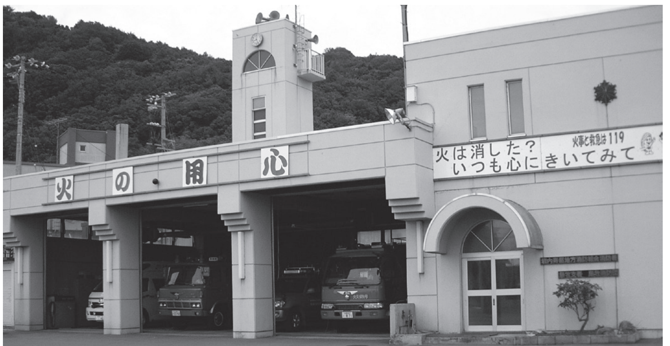
▲岩内・寿都地方消防組合島牧支署
