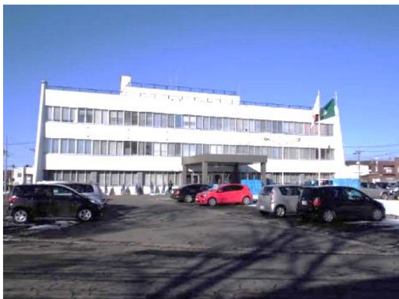
現庁舎の外観
