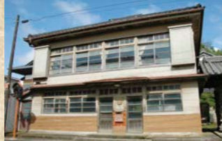
旧多古郵便局(MAP▶P31-E2) 多古町は郵便事業においても先進地で、明治5年(1872)5月に日本郵便の父・前島密の要請で千葉県第1号の郵便局[多古郵便取扱所]が開設されました。現在残る建物は、昭和17年(1942)に建て替えられたものです。
