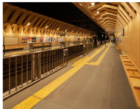
センサー付固定式ホーム柵
