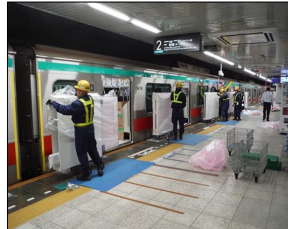
<搬出・設置状況>
