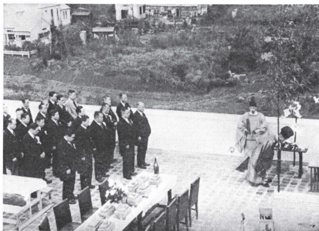
新本社屋上での竣工修祓式
