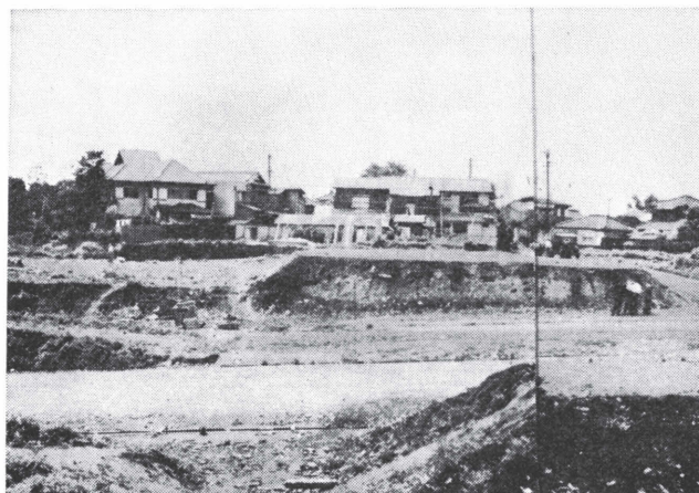
計画道路に面した昭和25年初頭の本社建設予定地
