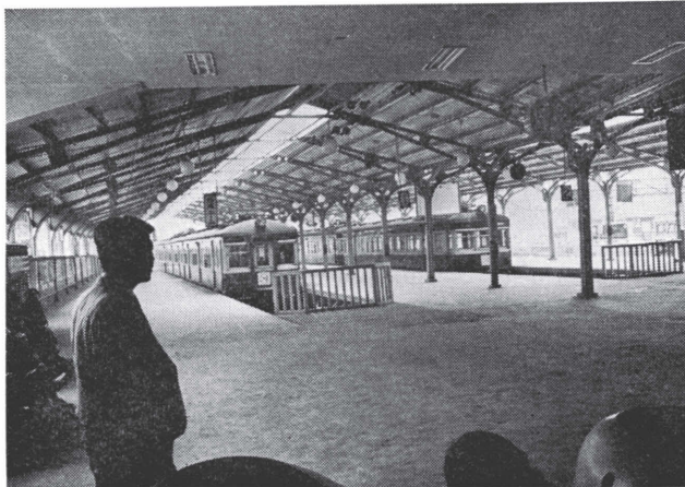
昭和25年8月、改良なった東横線渋谷駅
