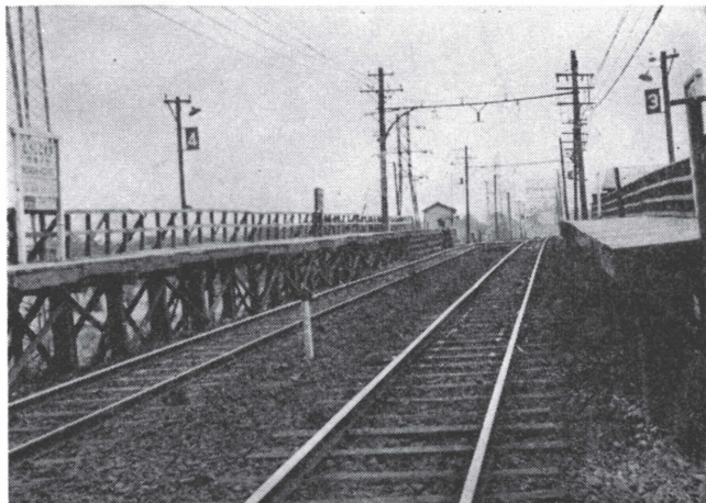
仮駅として設置された屋根なしの武蔵小杉駅
