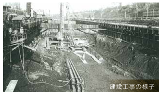
建設工事の様子
