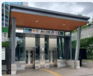
▲エレベーター整備
