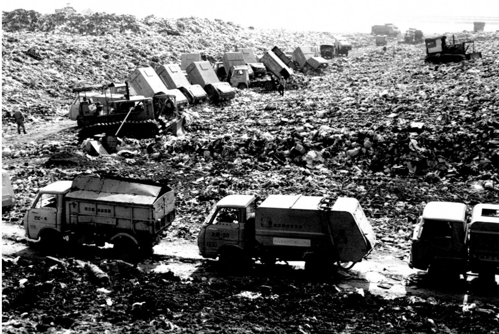
15号地埋立処理場(若洲)の埋立状況
