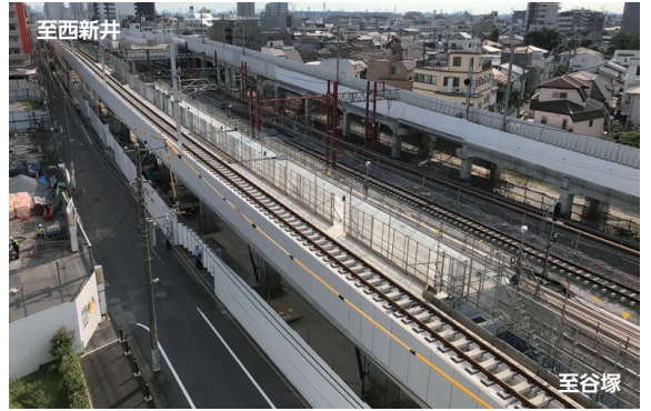
△使用開始した高架橋
