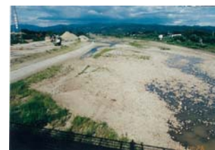
渇水時の状況(3) [上野川橋]
