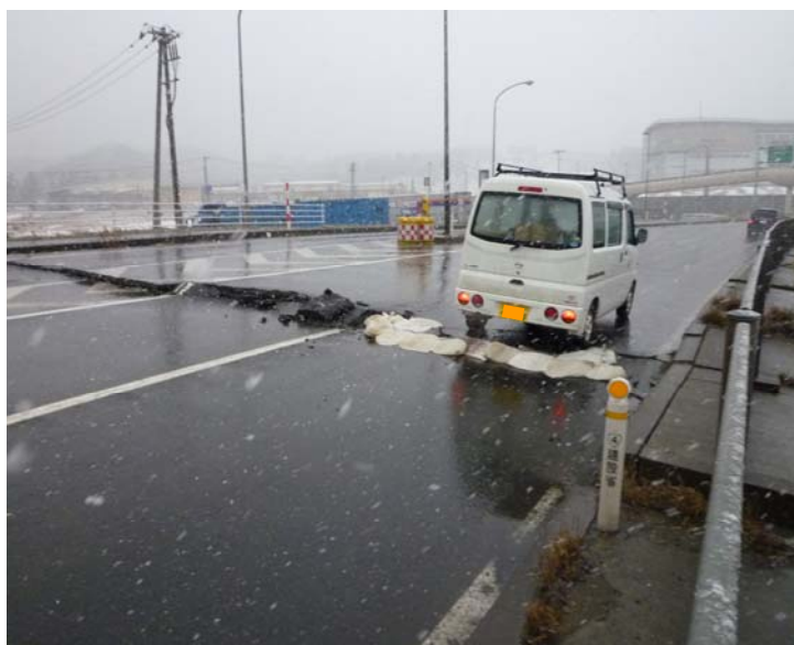
▲⑨大崎市三本木字鹿野沢地内
