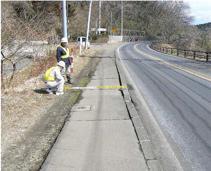
▲②仙台市青葉区八幡七丁目地内
