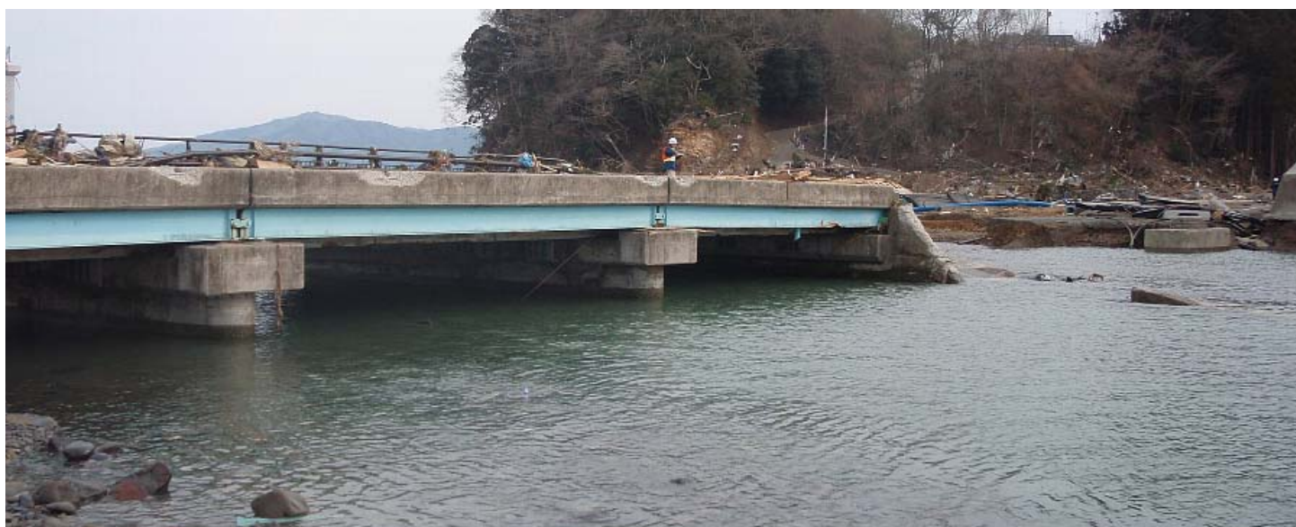
▲⑮南三陸町志津川字塩入地内（水尻橋）
