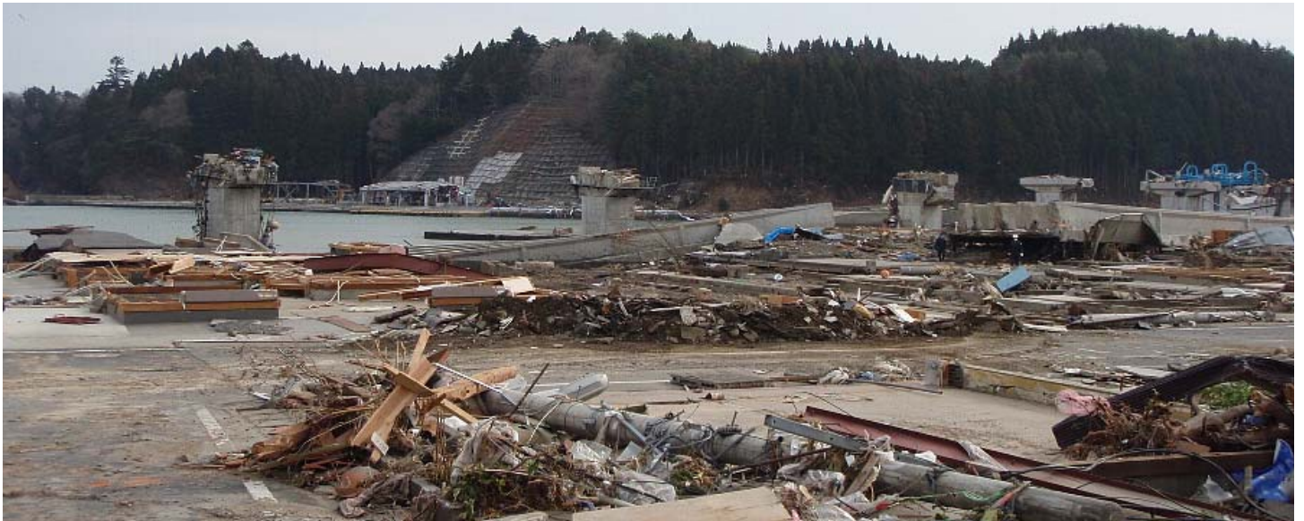
▲⑲南三陸町歌津字伊里前地内(歌津大橋)
