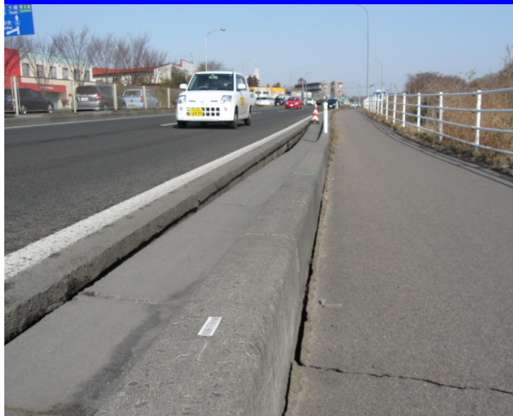
▲⑦仙台市泉区七北田地内
