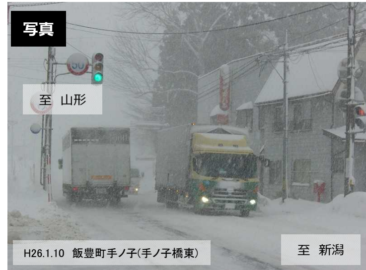
【写真1】国道113号の冬期道路状況
