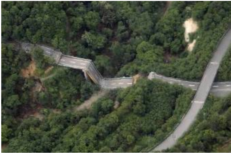
げんびちょう 岩手県一関市巖美町地内 【祭時(まつるべ)大橋落橋現場】
