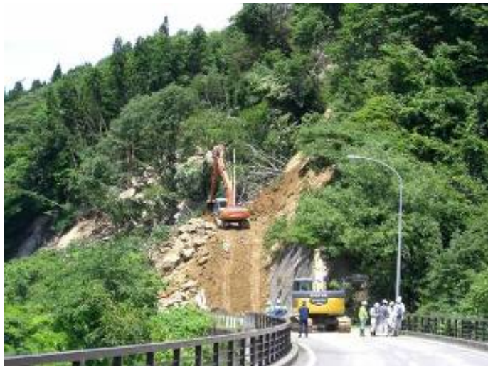
国道342号 岩手県一関市巖美町地内 矢びつダム周辺 【15日 崩落土砂撤去作業開始】
