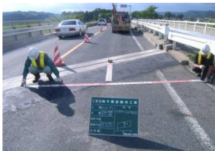
【すりつけ作業完了状況】 ・復旧完了(通行規制解除:6/14 17:49)
