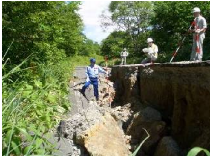
宮城県栗原市 国道398号の被災状況調査
