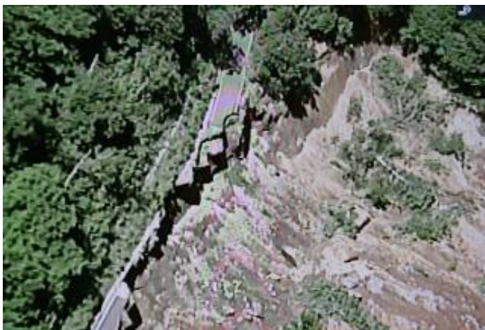
岩手県一関市巖美町地内 (すかわ 須川温泉より3km程度一関市側) 【路面崩落現場】
