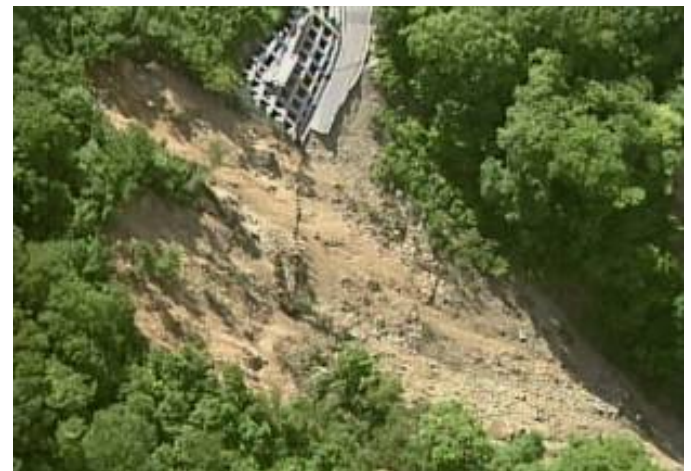
岩手県一関市巖美町地内 (しんゆ 真湯温泉より約1km秋田県側) 【路面崩落現場】
