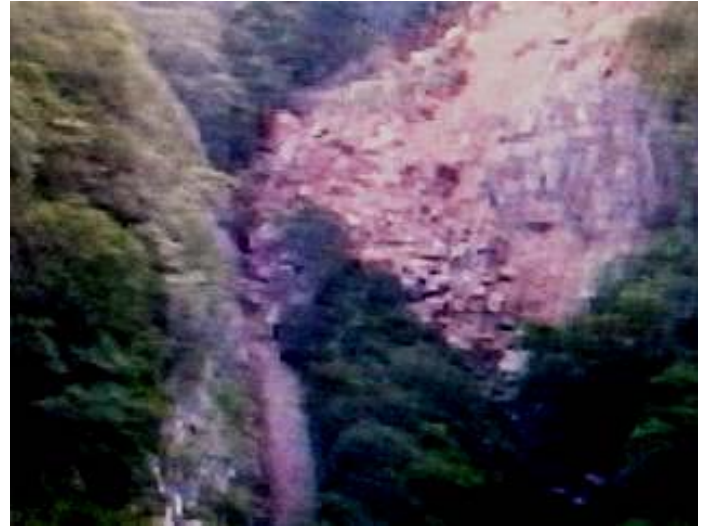
(主)築館栗駒公園線 宮城県栗原市柳沢地内 【土砂崩落現場】
