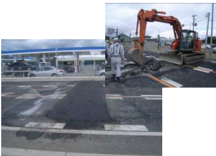
【14日 舗装隆起部の撤去作業】 ・14日 復旧完了(通行規制解除:6/14 14:10)
