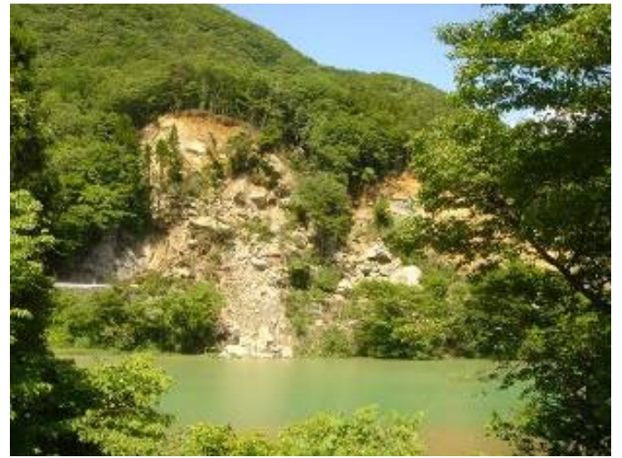
岩手県一関市巖美町地内 【矢びつダム付近の土砂崩落現場】
