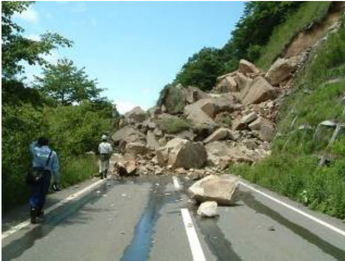
つきぎたいら 岩手県一関市巖美町槻木平地内 【土砂崩落現場】
