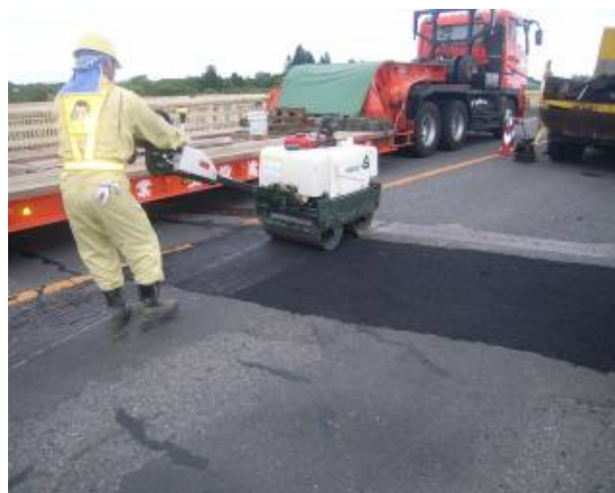
【すりつけ作業状況】 ・復旧完了(通行規制解除6/14 16:47)
