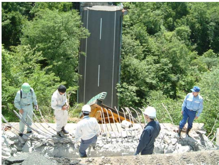
岩手県一ノ関市 国道342号 祭時(まつるべ)大橋の調査
