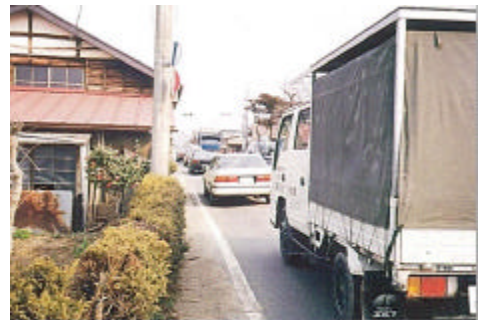
道路幅員が狭く、歩道未整備であるため、自動車と歩行者が介在し交通事故発生危険性が高い状況
