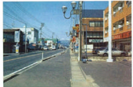
電線除去による都市景観の改善や、電柱除去による歩行空間の安全性向上が求められる状況
