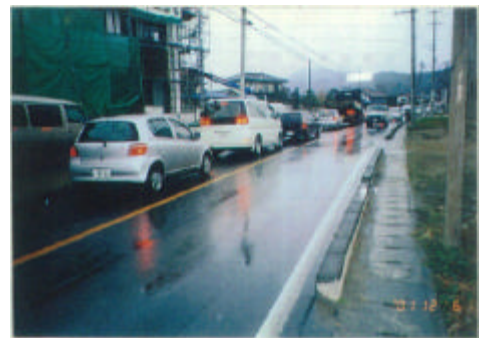
右折レーン未整備のため、右折車両の発生により直進車両の走行が阻害され、交通渋滞が発生している状況
