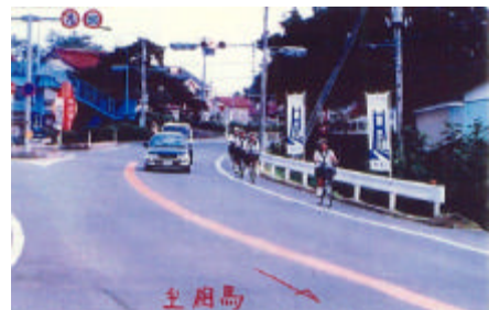
通学路に歩道が整備されておらず、通学児童が交通事故の危険性にさらされている状況
