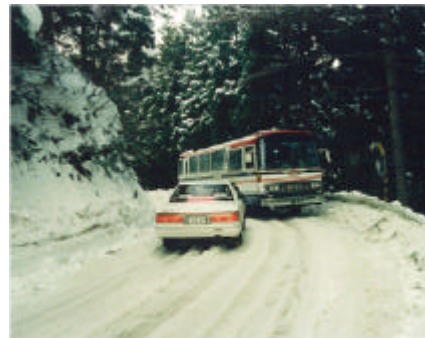
積雪時の幅員狭小により自動車の離合困難が発生している状況
