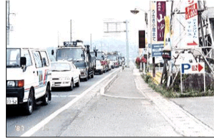
前後区間は 4 車線供用であるが、当該区間のみ 2 車線供用であるため交通ボトルネックとなり、著しい渋滞が発生している状況
