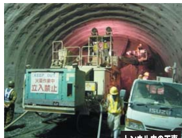
トンネル内の工事 切羽の様子
