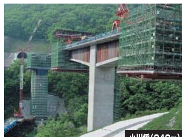
小川橋(243m) 張り出し工法
