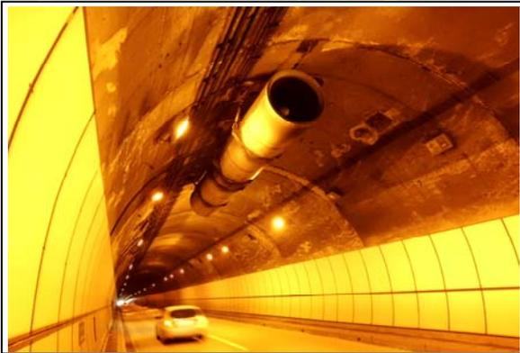
○天井板を撤去後、ジェットファンを1基ずつ設置します。
