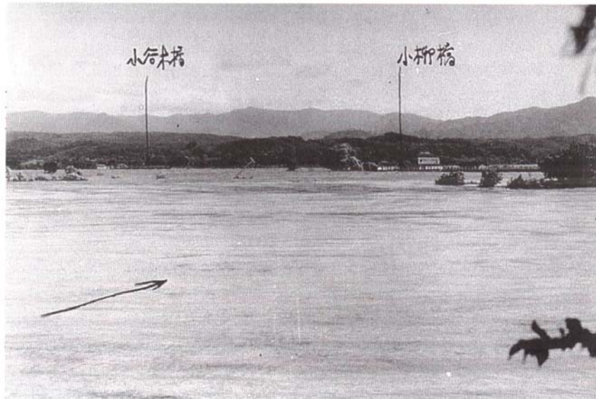
③北上川小谷木橋周辺冠水状況(奥州市)
