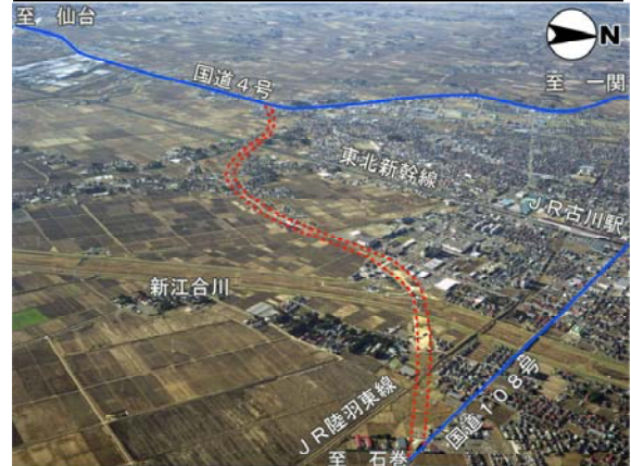
古川東バイパス整備状況 (L=5.1km) (国道108号から国道4号方面を望む)
