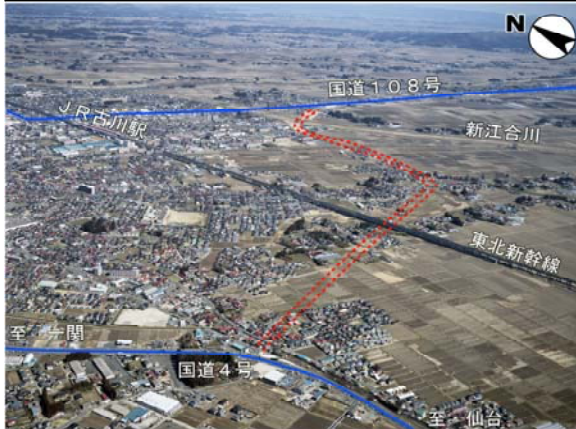
古川東バイパス整備状況 (L=5.1km) (国道4号から国道108号方面を望む)
