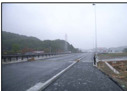
【白河橋(下り線)現況】 東京方面から郡山方面を望む
