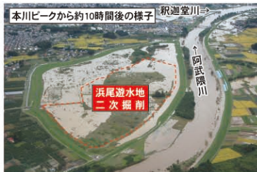
平成23年9月台風15号による浸水被害 (阿武隈川上流浜尾地区(浜尾遊水地))
