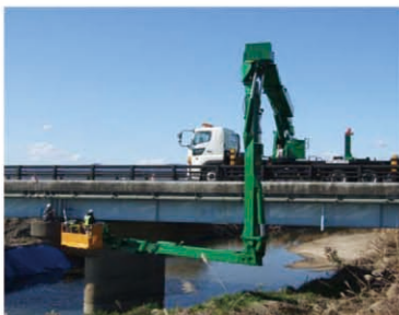
橋梁点検車による点検
