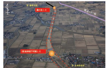
会津縦貫北道路 会津坂下河東IC(仮)～湯川北IC(仮)を臨む
