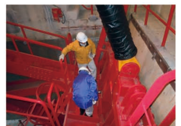
放流ゲートの点検状況
