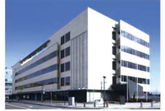
▲盛岡第2地方合同庁舎（完成写真）
