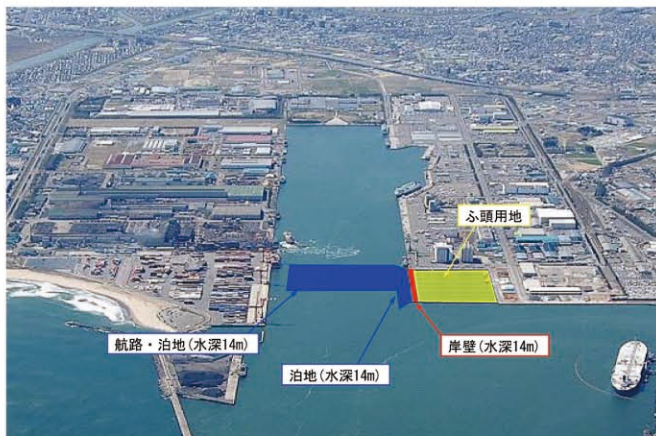
仙台塩釜港 中野地区 国際物流ターミナル
