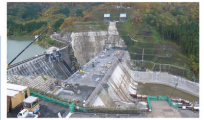
本体コンクリート打設中の津軽ダム (青森県中津軽郡西目屋村)
