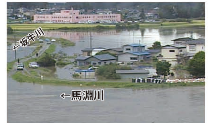
平成23年9月台風15号による浸水被害 (馬淵川八幡地区)
