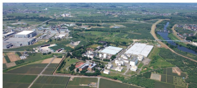
岩木川浄化センター(青森県流域下水道)
