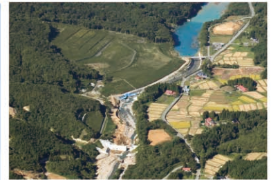
建設が進む市野の原砂防堰堤 直轄特定緊急砂防事業(岩手県側)
