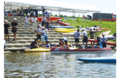
低水護岸の利用状況(最上川水系/河北町)▶
