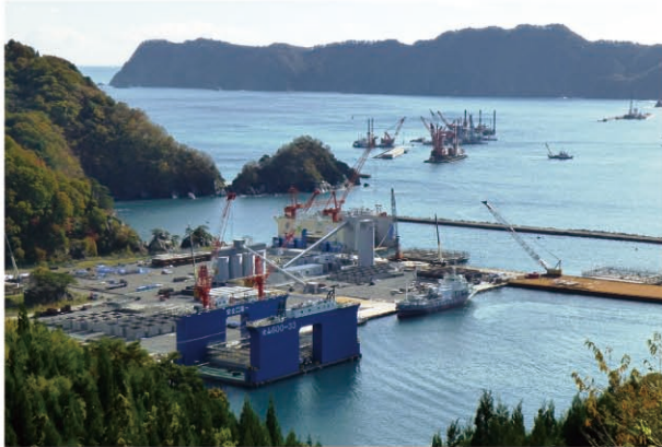
釜石港 湾口防波堤ケーソン製作
