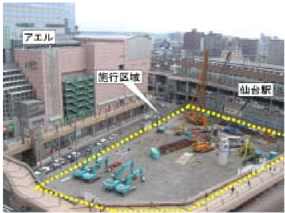
< 解体後の地区状況 >
